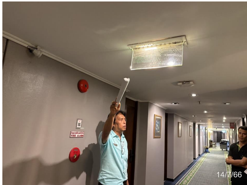
รูปที่ 2-9 การสุ่มตรวจสอบการทำงานของป้ายแสดงทางหนีไฟ บริเวณชั้น 4 ตึก Tower wing
